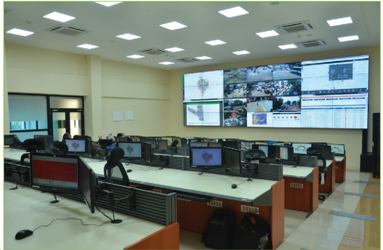
Fig. 4: The Vadodara ICCC
